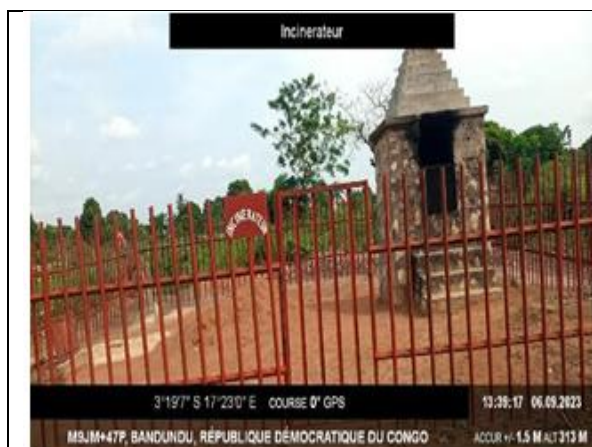
Photo 12: Fosse à placenta et l'incinérateur de l'Hôpital Général de Référence de Bandundu Ville
