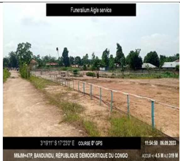
Photo 7: clôture du Funérarium Aigle Service
