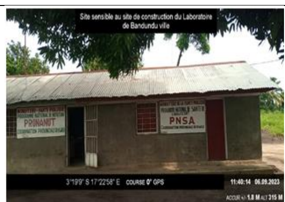
Photo 11: Bâtiment abritant trois services provinciaux dont PRONANUT, PNSA, PNSM
